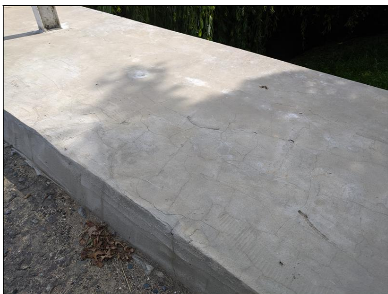
Popraskaný sanovaný povrch římsy
