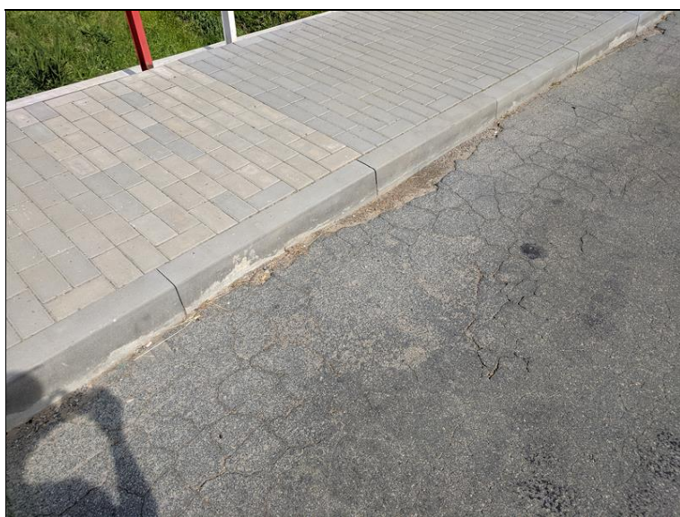
Degradace vozovky v okolí obrubníků
