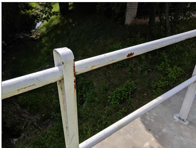
Koroze zábradlí
