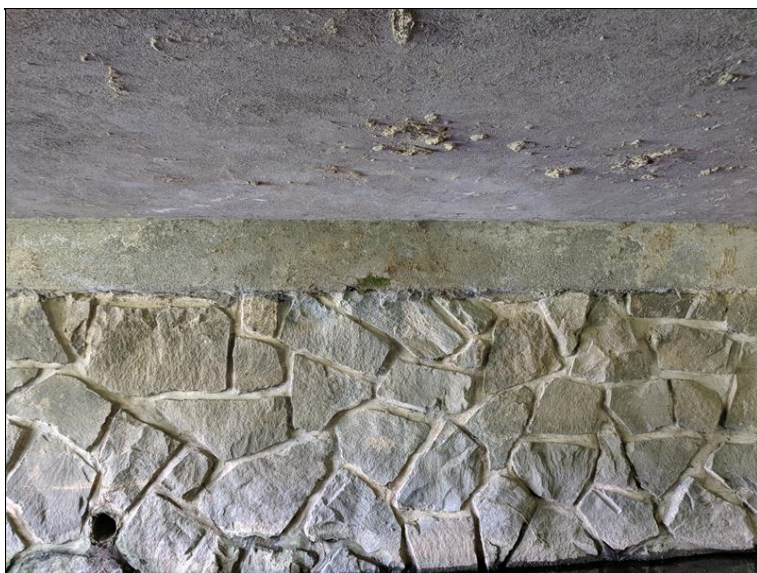
Pohled na OP1, stopy po zatékání
