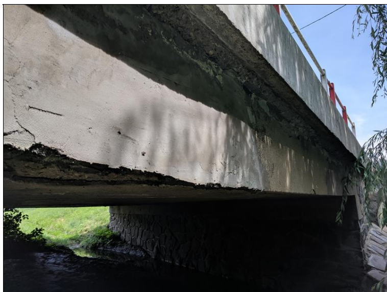
Odpadlá omítka z podhledu na levé straně NK, stopy po zatékání
