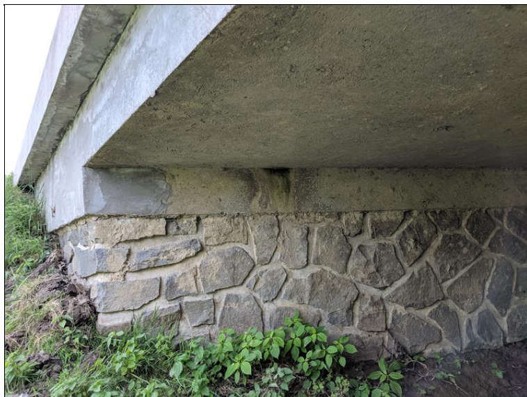
Zatékání na OP1 vpravo
