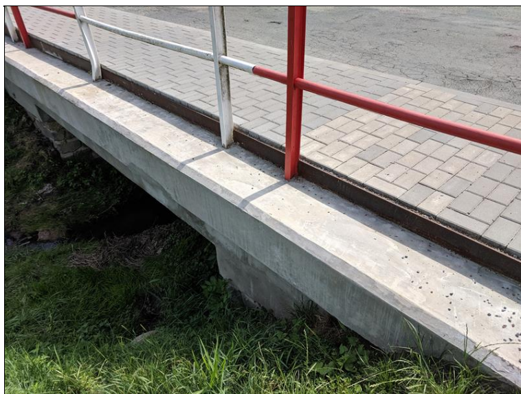
Koroze pásoviny ohraničující dlažbu chodníku
