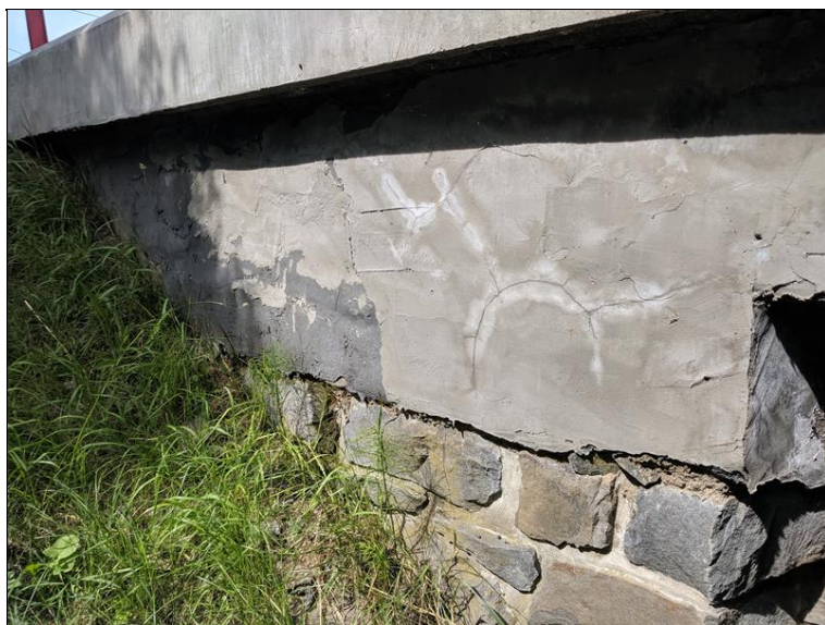
Pohled na levé křídlo OP2. Nerovný, nesjednocený povrch s prasklinami
