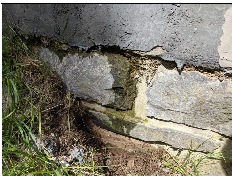
Zatékání prac. spárou na levém křídle OP2
