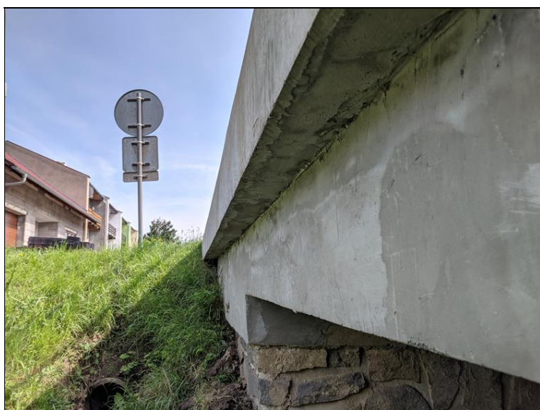
Pohled ze spodní strany pravé římsy, chybí okapní profil, zatékání po římse
