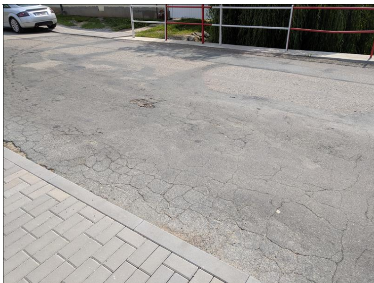
Kryt nerovný s množstvím trhlin, výtluky
